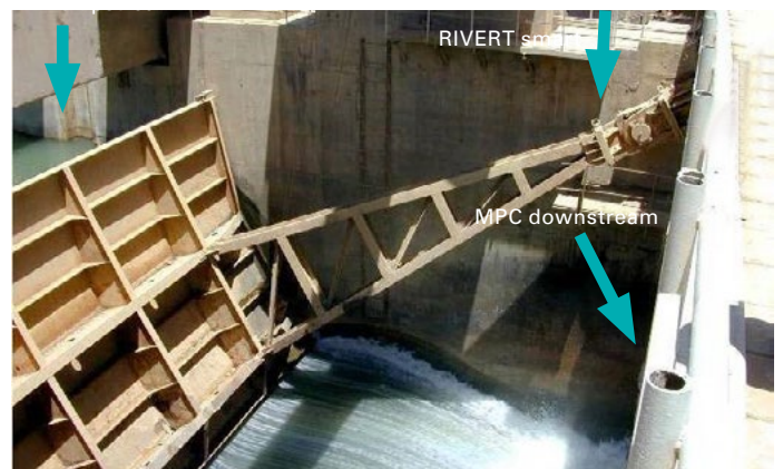
Photo d'une installation
